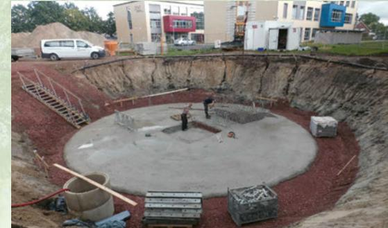
zeit die Bauvorbereitungen für das neue „Forum Technik“. Das Besondere an dem geplanten Gebäude wird seine klimaneutrale Wärme- und Kältetechnik sein, bei der eine Eisspeicherheizung zum Einsatz kommen wird. Zu diesem Zweck wurde bereits eine Betonzisterne mit 12 m Durchmesser und ca. 270 m<sup>3</sup> Fassungsvermögen vier Meter tief ins Erdreich gebaut – der Eisspeicher.
